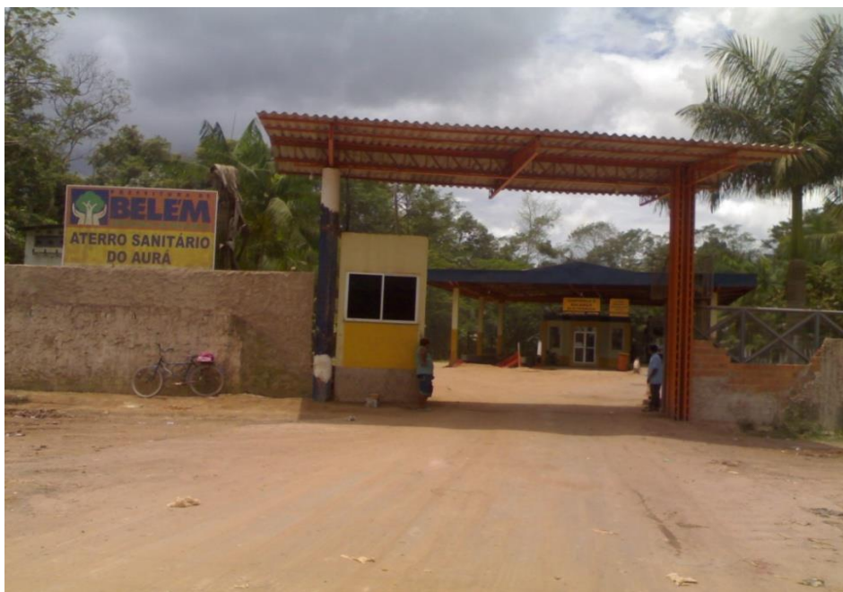
Figura 6. Acesso ao Aterro do Aurá
